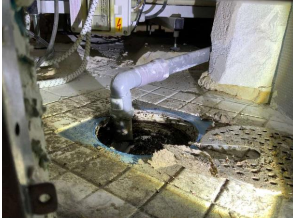
Bild 20: Invändigt, Övervakning, Badrum Bild under badkaret
