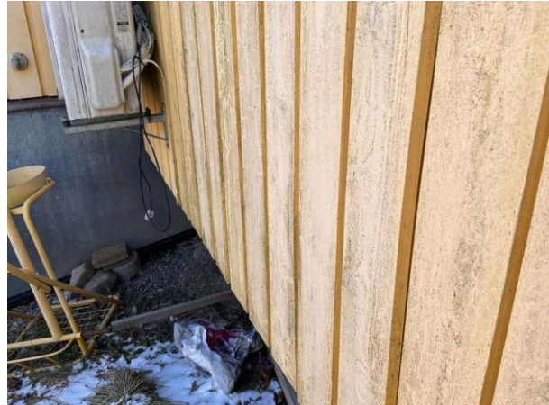
Bild 2: Utvändigt, Fasad, Missfärgningar på träpanel mot uterum och gavel
