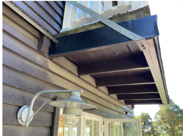
Bild 4: Utvändigt, Balkong, Balkong, Genomgående åsar se riskanalysen
