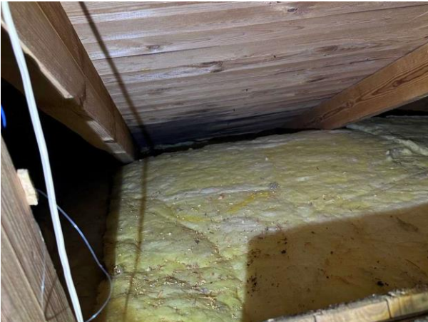
Bild 7: Utvändigt, Vind, Huset är självdragsventilerat se riskanalysen Vinden är tilläggsisolerad Spår av läckage noterades vid ett takstolsfack Spår av kondens mi...
