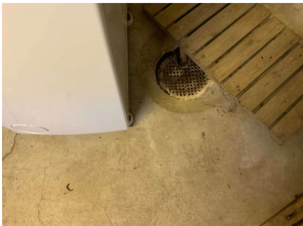
Bild 25: Invändigt, Källarplan, Tvättstuga, Äldre gjutjärnsbrunn
