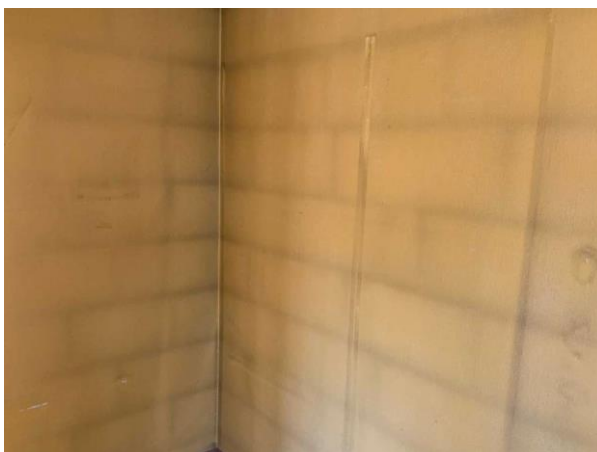
Bild 30: Invändigt, Entréplan, Sovrum 1, Köldbryggor på väggarna
