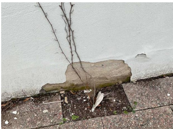
Bild 1: Utvändigt, Grundmur/Hussockel, Putssläpp och Färgsläpp finns på sockeln
