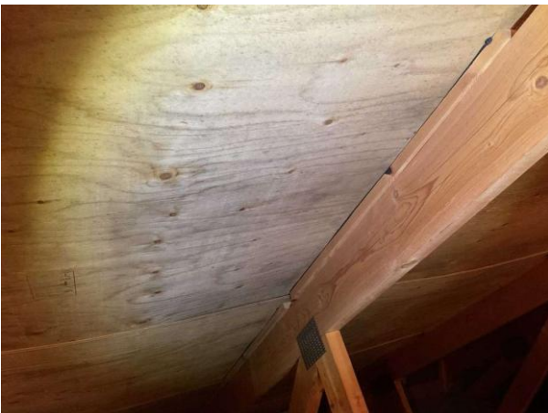
Bild 5: Utvändigt, Vind, Lokalt på vinden noterades det mikrobiell på växt på underlagsskivorna vanligt förekomma
