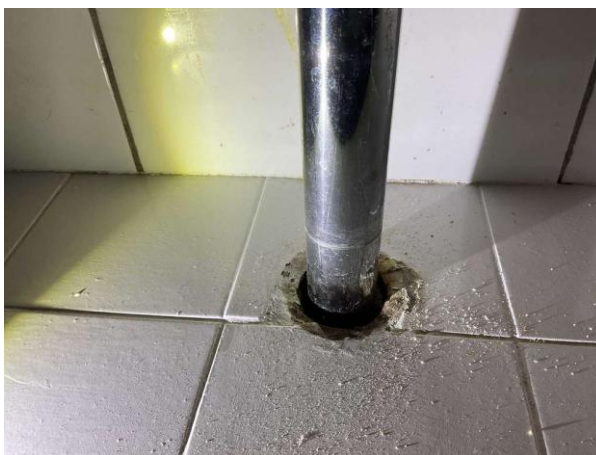
Bild 10: Invändigt, Övervåning/halvplan, Wc, Avloppet till handfatet är inte skarvat ovan tätskikt
