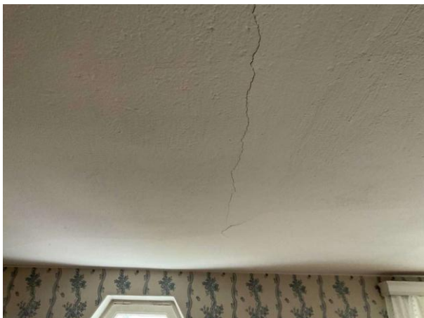
Bild 7: Invändigt, Mellanplan, Sovrum 1, Spricka noteras på innertaket Missfärgningar noteras på parketten vid altandörren
