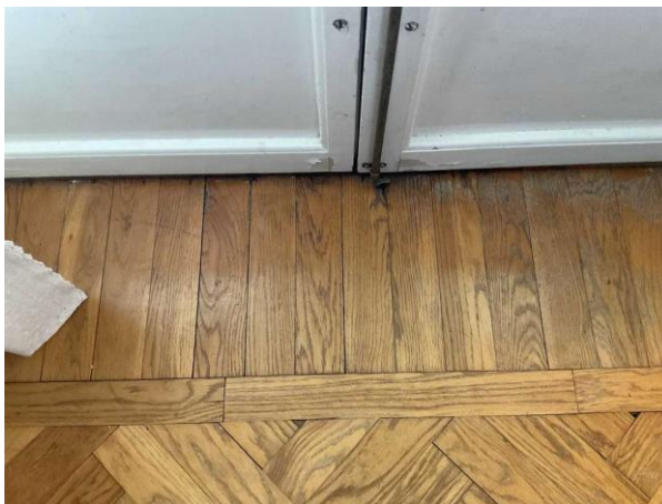
Bild 8: Invändigt, Mellanplan, Sovrum 1, Spricka noteras på innertaket Missfärgningar noteras på parketten vid altandörren
