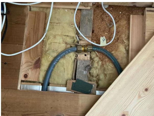
Bild 15: Invändigt, Entréplan, Vardagsrum, Golvvärmslang är skarvad och dold i golvet
