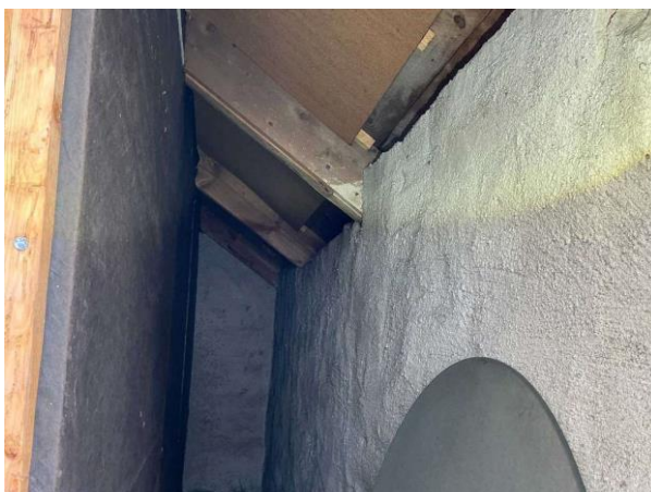
Bild 2: Utvändigt, Kattvind med ingång från balkong, Besiktad från luckan inget särskilt att notera
