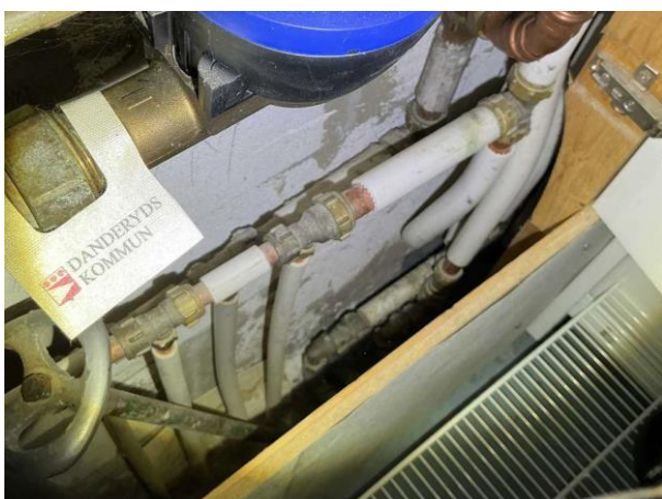
Bild 5: - Invändigt, Souterrängplan, Äldre plastmatta Klämringen är lös i golvbrunnen Lock saknas på eldosor Inbyggnad för inkommand...
