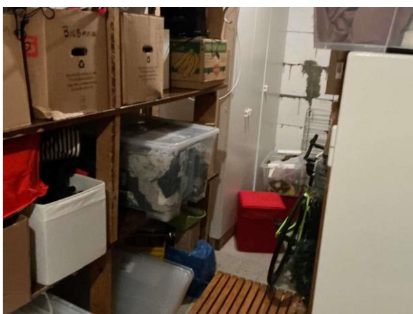
Bild 6: Invändigt, Souterrängplan, Rummet är till stora delar belamrat vid bohag, vilket begränsar besiktningen
