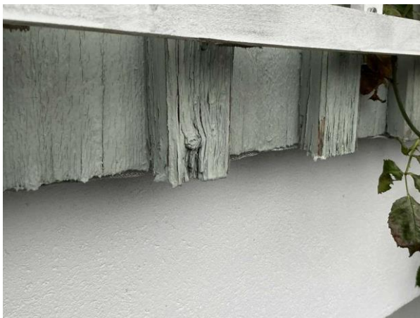
Bild 2: - Utvändigt, Fasad, Färgsläpp och rötskador noterades i panelens nedre kant mot solsida Klängväxter mot fasad
