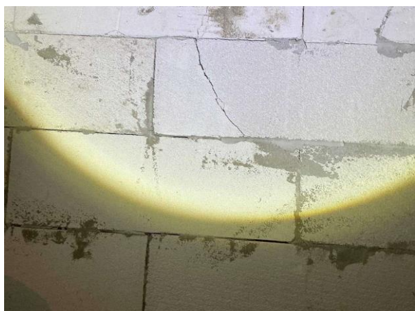
Bild 21: - Invändigt, Källarplan, Äldre rostig gjutjärnsbrunn Fuktgenomslag i källarväggar med mögelpåväxt på golv Synlig rostig ar...
