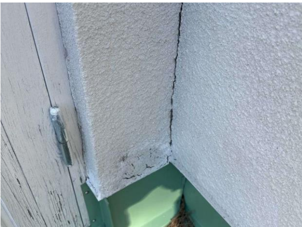
Bild 5: - Utvändigt, Fasad, Putslagning och spricka i puts noterades på fasad från låga taket Fasaden är delvis tilläggsisole...
