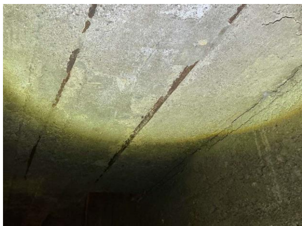
Bild 19: - Invändigt, Källarplan, Äldre rostig gjutjärnsbrunn Fuktgenomslag i källarväggar med mögelpåväxt på golv Synlig rostig ar...
