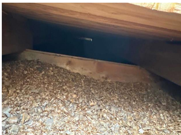
Bild 9: Utvändigt, Vind, Vinden är väldigt begränsat besiktad ca 1 meter då utrymmet bara är ca 30cm från spånisoleringen
