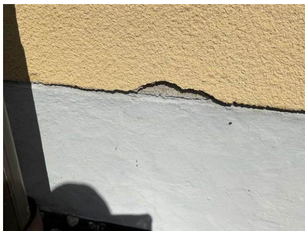
Bild 8: - Utvändigt, Fasad, Flagor, Färgsläpp, lagningar, sprickor och bomputs förekommer behov av reparation omputsning Lös...
