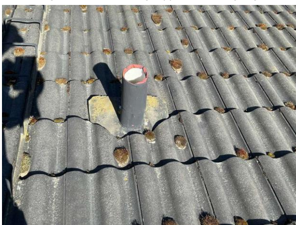
Bild 22: - Utvändigt, Yttertak, Tak ovan huvudbyggnad besiktat i anslutning till taksäkerhet Färgsläpp och missfärgningar av takf...
