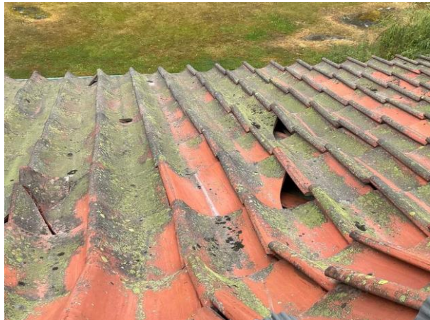
Bild 4: - Utvändigt, Yttertak, Äldre tak med kommande takomläggning Se riskanalysen Taket har besiktats från takfoten och balkon...
