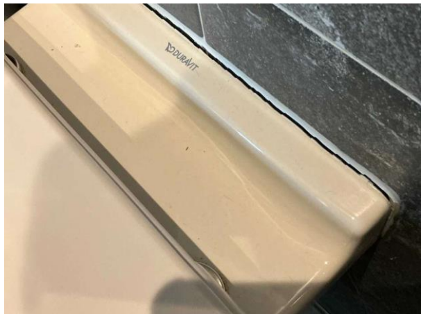
Bild 6: - Invändigt, Entréplan, Tät tröskel saknas Kvalitetsdokument saknas Skvallerör saknas för inbyggnad av spolcistern toale...
