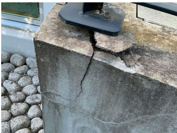
Bild 3: - Utvändigt, Grundmur/Hussockel, Skadad betongmur som håller räcke Fiberduk och topplist synlig på del av grunden bör täckas över ...
