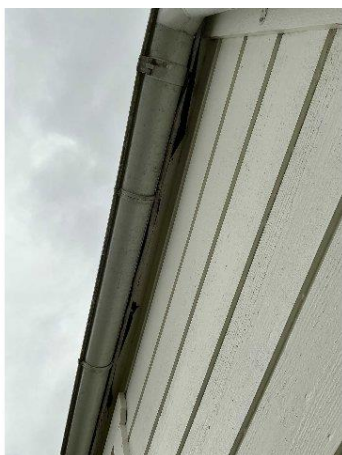
Bild 3: - Utvändigt, Yttertak, Taket har besiktats i anslutning till taksäkerhet. Äldre tak och takfönster samt plåtgenomföringar...
