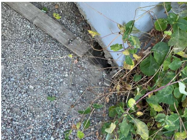
Bild 1: Utvändigt, Mark, Äldre dränering, en dränerings tekniska livslängd beräknas till 25år, om det är rätt utfört och m...
