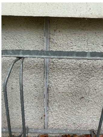
Bild 1: - Utvändigt, Grundmur/Hussockel, Torr mjukfog noteras vid skarvarna Lokalt noteras enstaka spricka i grundmur
