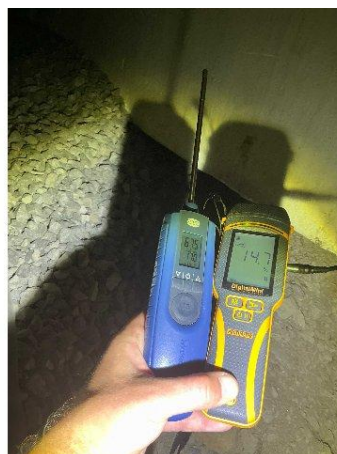
Bild 2: - Utvändigt, Grund, Uteluftventilerad Fuktkontroll utförd under gränsvärde se bilaga 4
