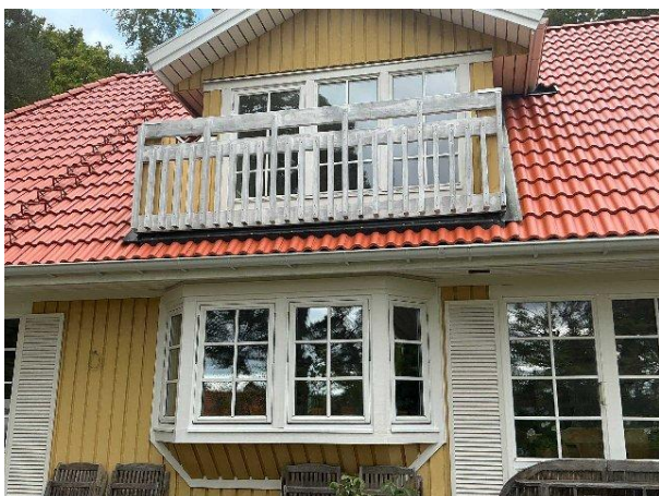
Bild 21: - Invändigt, Övervåning, Underbyggd balkong
