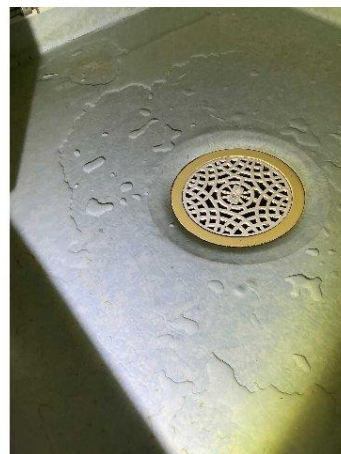
Bild 12: - Invändigt, Entréplan, Äldre våtrum med plastmatta på golvet
