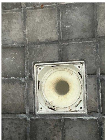
Bild 7: - Invändigt, Övervakning, Renoverat 2008 Kvalitetsdokument saknas Klämrings saknas i golvvbrunn Äldre golvvbrunn Rör i vägg i ...
