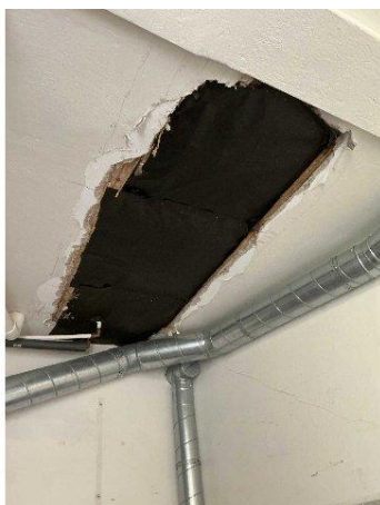
Bild 1: - Invändigt, Entréplan, Hål i innertak...
